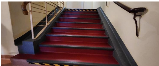
Zdjęcie nr 6 – Schody
